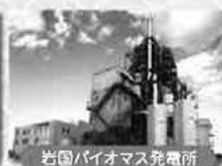
岩国バイオマス発電所
