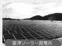
福津ソーラー発電所
